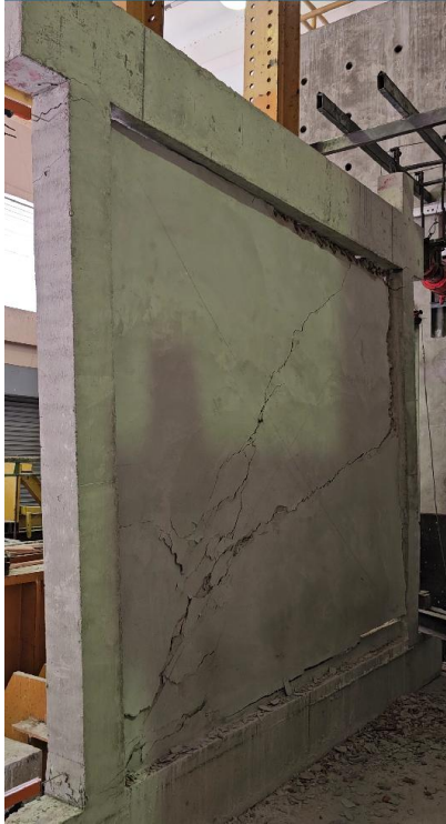
รูปที่ 17 การแตกร้าวในโครงข้อแข็งที่มีวัสดุก่ออิฐมอยู
