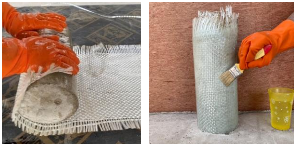
รูปที่ 5 การโอบรัดด้วยพอลิเมอร์เสริมเส้นใยแก้ว
