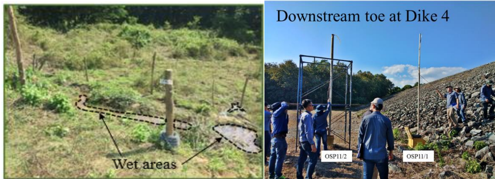
รูปที่ 10 พื้นที่ชุ่มน้ำและการต่อท่อ 4 เมตร เพื่อตรวจวัดแรงดันน้ำ [17]
