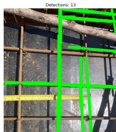
รูปที่ 6 ตัวอย่างการตรวจจับเหล็กเสริมจากภาพถ่ายด้านบน
