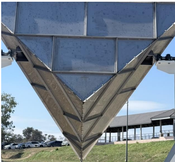
รูปที่ 5 แสดงให้เห็นรูที่เจาะบนแผ่นสแตนเลสของ Corner Reflectors
