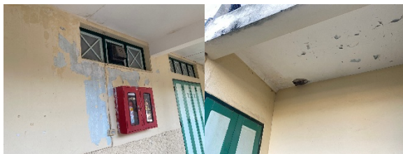
รูปที่ 6 ตัวอย่างความเสียหายของผนังที่สีเสื่อมสภาพ
