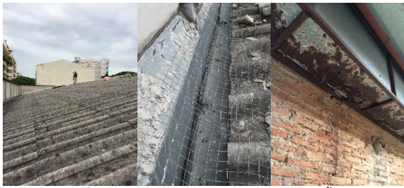
รูปที่ 5 ตัวอย่างความเสียหายของหลังคาและรางน้ำฝน
