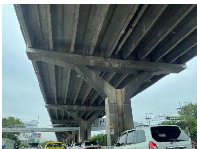
รูปที่ 8 โครงสร้างทางยกระดับดอนเมือง
