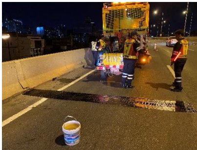
รูปที่ 3 งานซ่อมบำรุง Expansion Joint
