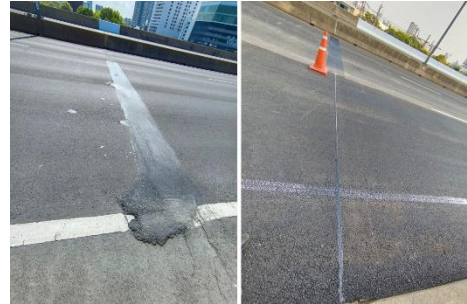
รูปที่ 12 ก่อนและหลังปรับปรุงผิวทาง
