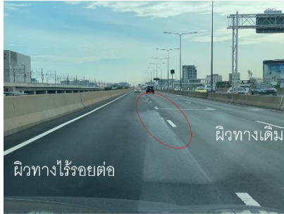
รูปที่ 15 น้ำขังภายในผิวทาง
