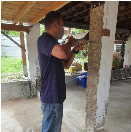
รูปที่ 2 การทดสอบกำลังอัดคอนกรีตด้วยค้อนกระแทก
