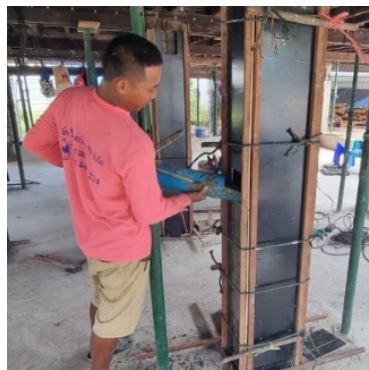
รูปที่ 12 การเทคอนกรีต
