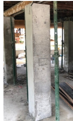
(ก) เสาที่เทด้วยคอนกรีต
