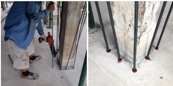
(ค) เติมน้ำยาเคมีในรูเจาะ
