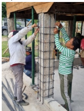
(จ) ผูกเหล็กปลอกหุ้มเสาคอนกรีตเดิม
