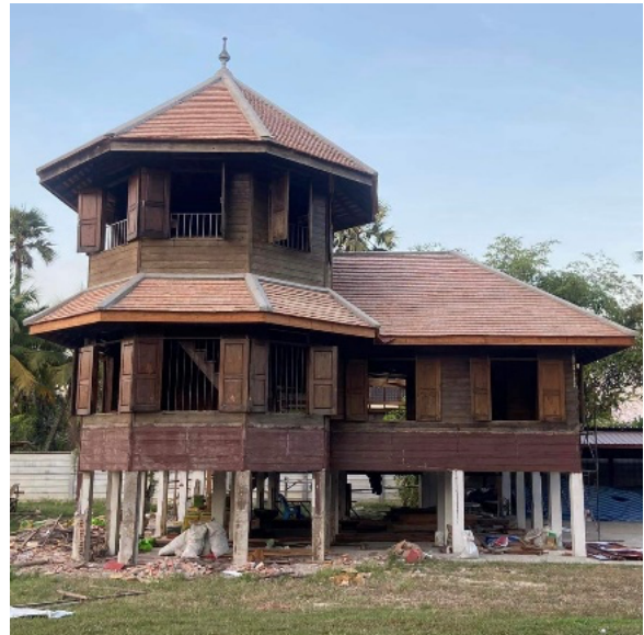
รูปที่ 1 บ้านไม้โบราณรูปทรงแปดเหลี่ยมยกใต้ถุนสูง
