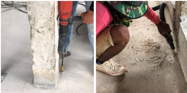
(ก) เจาะรูที่คอนกรีตเดิม
