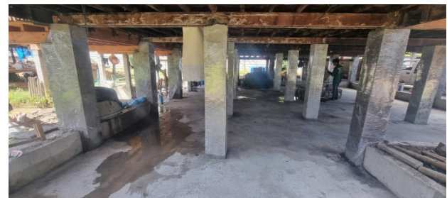
รูปที่ 13 เสาที่เทด้วยคอนกรีตและมอร์ตาร์แบบไหลอัดแน่นด้วยตัวเอง
