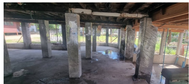
รูปที่ 14 โครงสร้างเสาหลังการปรับปรุงเสริมความแข็งแรงด้วยคอนกรีตเทหุ้มเสา
