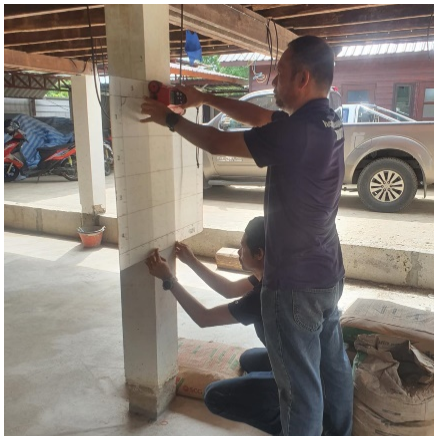
รูปที่ 3 การตรวจสอบตำแหน่งเหล็กเสริมในคอนกรีตด้วยเครื่องสแกน
