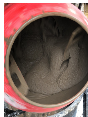
รูปที่ 11 การผสมมอร์ตาร์ไหลอัดแน่นด้วยตัวเอง
