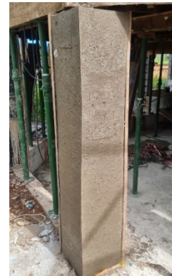
(ข) เสาที่เทด้วยมอร์ตาร์
