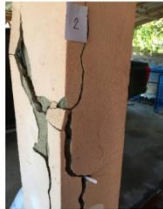
รูปที่ 1 โครงสร้างเสาที่เหล็กเส้นถูกกัดกร่อนเป็นสนิมและต้นคอนกรีตหุ้มแตก
