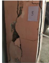
รูปที่ 1 โครงสร้างเสาที่เหล็กเส้นถูกกัดกร่อนเป็นสนิมและต้นคอนกรีตหุ้มแตก
