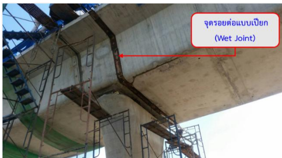
รูปที่ 2 การเทคอนกรีตบริเวณจุดรอยต่อแบบเปียก (Wet Joint)
