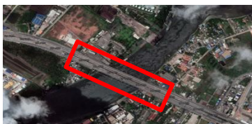
รูปที่ 3-1 สะพานข้ามแม่น้ำท่าจีน ทางหลวงหมายเลข 35
