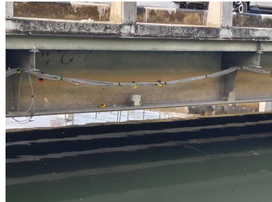
(ข) การติดตั้งอุปกรณ์วัดค่าการเสียรูปเชิงมุม
