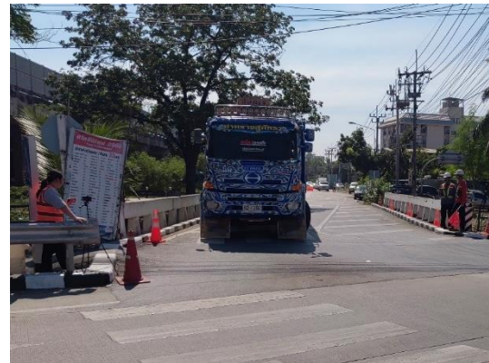
(ข) การทดสอบกำลังรับน้ำหนักสะพานแบบพลศาสตร์ รูปที่ 9 การทดสอบกำลังรับน้ำหนักสะพานทั้งหมด 4 กรณี
