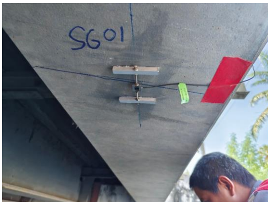
(ก) การติดตั้งอุปกรณ์วัดค่าความเครียด
