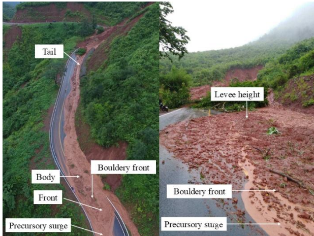
รูปที่ 1 ตัวอย่างลักษณะทางกายภาพของการไหลหลากของดินโคลนรวมถึงเศษซากต่างๆที่พัดพามาพร้อมกับกรไหล ในเขตทางหลวงหมายเลข 1081 ตอน อ.บ่อเกลือ-อ.เฉลิมพระเกียรติ จ.น่าน
