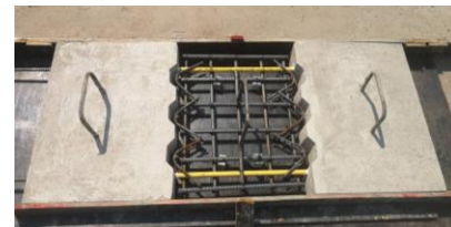
รูปที่ 6 Multiple Shear Key ใส่เหล็กเสริมรับแรงเฉือนรูปสี่เหลี่ยมคางหมู (หน่วยเป็นมิลลิเมตร)
