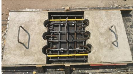
รูปที่ 8 Multiple Shear Key ใส่เหล็กเสริมรับแรงเฉือนรูปทรงกลม (หน่วยเป็นมิลลิเมตร)
