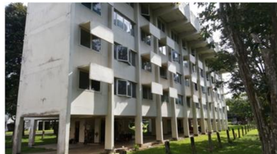
รูปที่ 1 อาคารที่เกิดการยกตัวของอาคาร
