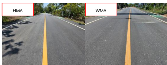
รูปที่ 25 ลักษณะทางกายภาพของแปลงทดลองหลังก่อสร้าง 2 เดือน
