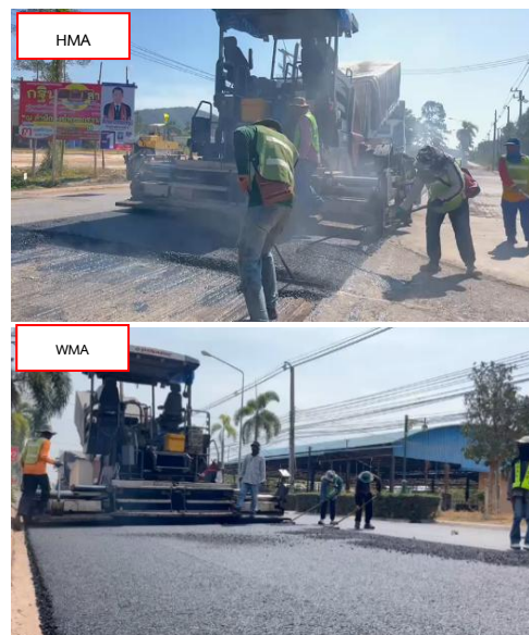
รูปที่ 32 ควันบริเวณรถบรรทุกสู่เครื่องปูส่วนผสม HMA และ WMA
