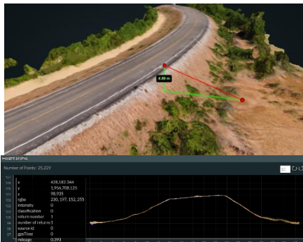
รูปที่ 3 แบบจำลองสามมิติที่สร้างจากภาพถ่ายจากอากาศยานไร้คนขับและการวิเคราะห์รูปทรงของคันทางถนน นพ 3017
