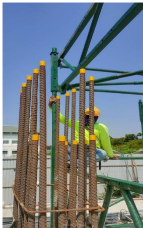
รูปที่ 2 การใช้งานข้อต่อเชิงกลในการก่อสร้าง
