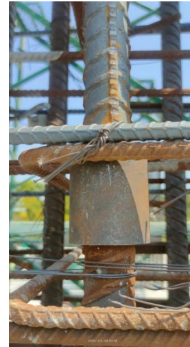
รูปที่ 3 การใช้งานข้อต่อเชิงกลในการก่อสร้าง
