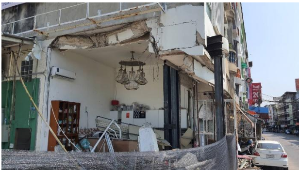
รูปที่ 3 การค้ำยันเพื่อเตรียมการซ่อมแซมอาคาร
