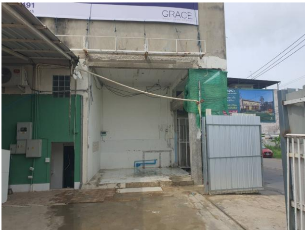
รูปที่ 8 โครงสร้างหลังการซ่อมแซมบูรณะ
