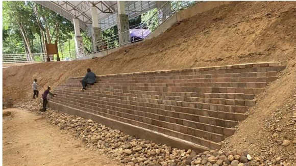
รูปที่ 13 ตัวอย่างการใช้ TOR Block ในการก่อสร้างกำแพงป้องกันดินถล่ม (รูปโดย สุทธิศักดิ์ ศรีลัมพ์)
