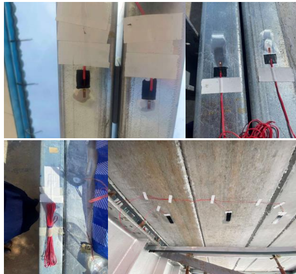
รูปที่ 5 การติดตั้ง Strain Gauges (SGs) บนองค์ประกอบโครงสร้างหลัก
