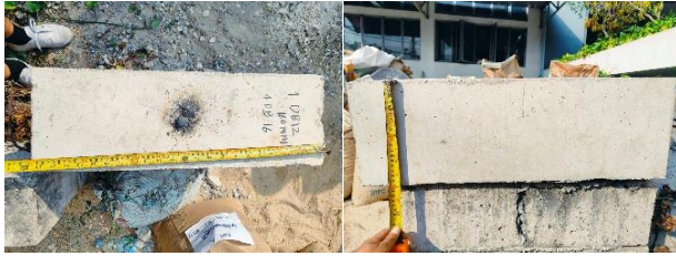
รูปที่ 13 การวัดแบบคลากของเหล็กเสริม (คอนกรีตแตกร้าวเล็กน้อย)
