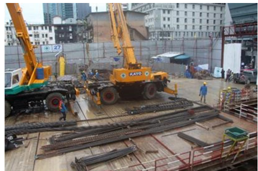
รูปที่ 6 การใช้เหล็กตัด-ดัดสำเร็จรูปในงานก่อสร้างอาคารสูง [2]
