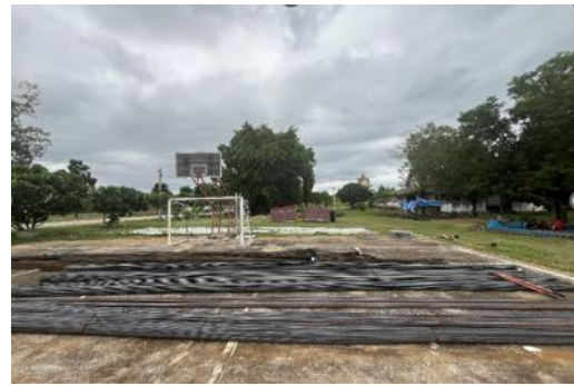
รูปที่ 2 การกองเก็บวัสดุเหล็กเสริมคอนกรีตที่ต้องอาศัยพื้นที่ปริมาณมาก
