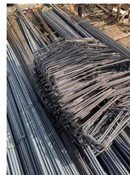
รูปที่ 7 การใช้เหล็กตัด-ดัดสำเร็จรูปในงานก่อสร้างบ้านพักอาศัย [2]
