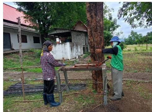
รูปที่ 3 การดำเนินงานตัดเหล็กที่ต้องอาศัยทักษะฝีมือ
