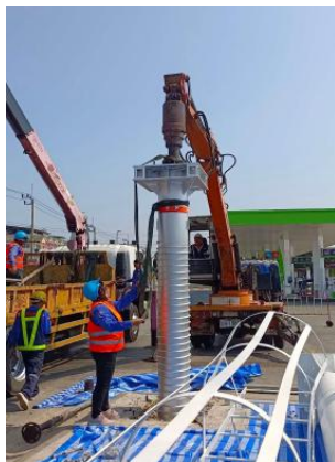
รูปที่ 8 การติดตั้งเสาเข็มสกรูขนาดใหญ่ FS355
