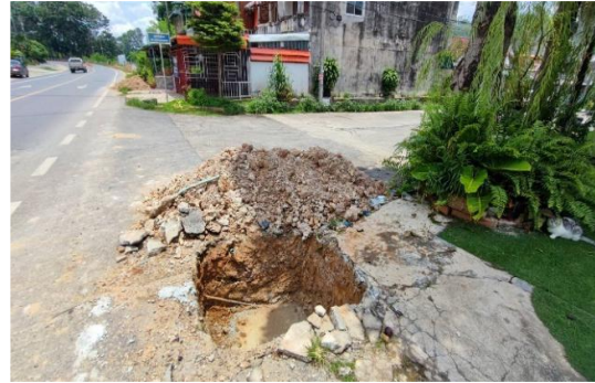
รูปที่ 4 การขุดเพื่อติดตั้งฐานเสาไฟฟ้าของเสาเข็มคอนกรีตทำให้เกิดสิ่งสกปรกบริเวณไหล่ทาง [16]
