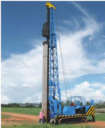
รูปที่ 2 การตอกเสาเข็มคอนกรีต
