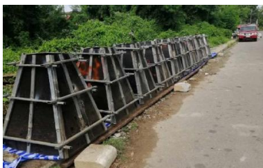
รูปที่ 3 การติดตั้งแบบหล่อของฐานเสาป้ายจราจรของเสาเข็มคอนกรีต [16]
