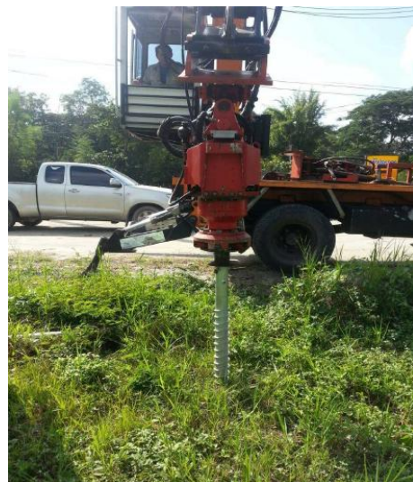
รูปที่ 5 การติดตั้งเสาเข็มสกรูบริเวณไหล่ทางข้างถนน
