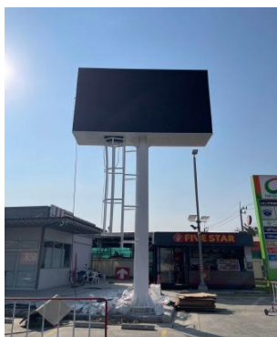
รูปที่ 9 การติดตั้งป้ายขนาดใหญ่โดยใช้นวัตกรรมฐานรากเสาเข็มสกรู
