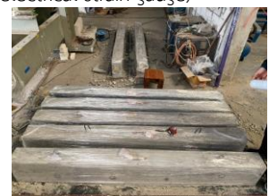
(ข) บ่มคอนกรีต
