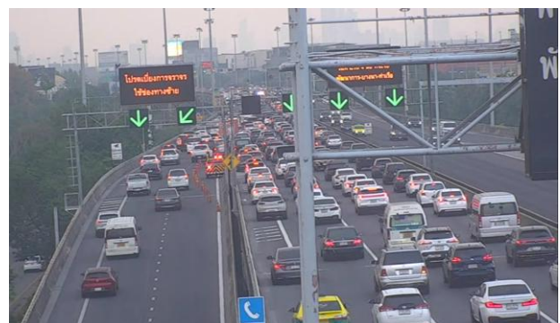
รูปที่ 5 ภาพจากกล้องโทรทัศน์วงจรปิด (CCTV)
