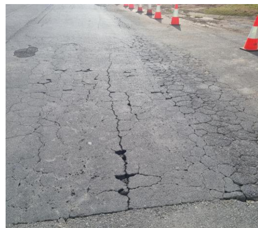
รูปที่ 21 ความเสียหายของผิวทางที่เกิดจากดินฐานรากเป็นดินอ่อนและมีระดับน้ำใต้ดินสูง
