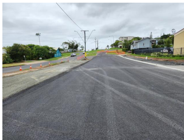
รูปที่ 23 ถนนหลังจากปรับปรุงด้วยแผ่นโยสังเคราะห์ชนิดมีเส้นโยดูดซึมน้ำ
