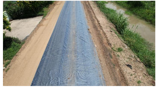
รูปที่ 14 การติดตั้งแผ่นใยสังเคราะห์ชนิดมีเส้นใยดูดซับน้ำลงบนชั้นดินรอง พื้นทางของถนนเรียบคลอง
