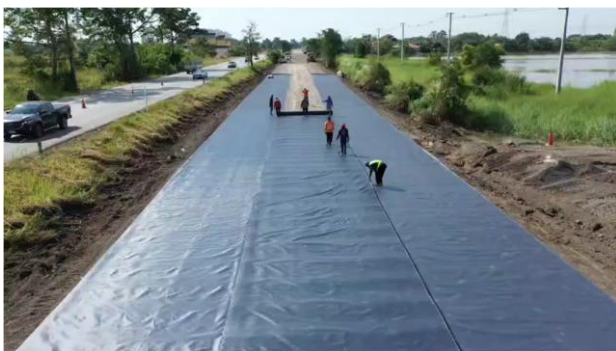
รูปที่ 17 การติดตั้งแผ่นใยสังเคราะห์ชนิดมีเส้นใยดูดซึมน้ำลงบนชั้นดินรอง พื้นทางของถนน [7]
