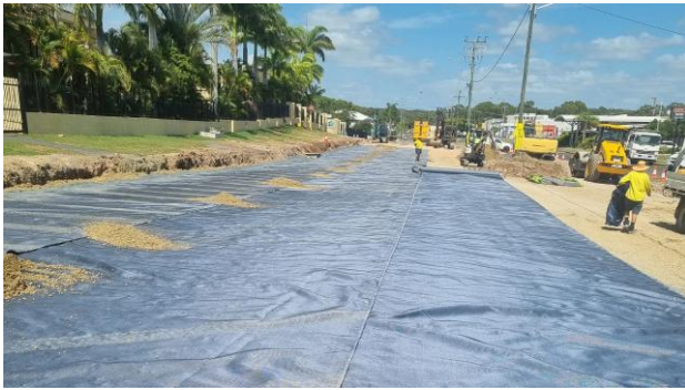
รูปที่ 22 การติดตั้งแผ่นโয়สังเคราะห์ชนิดมีเส้นโยดูดซึมน้ำลงบนชั้นดินรอง พื้นทางของถนน
