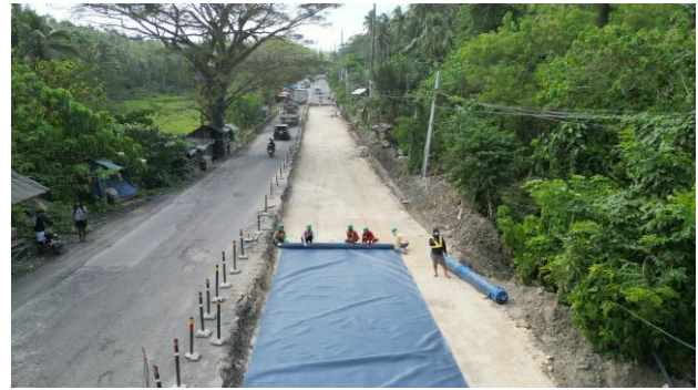
รูปที่ 20 การติดตั้งแผ่นโพลีเมอร์ชนิดมีเส้นใยดูดซับน้ำลงบนชั้นดินรองพื้นทางของถนน
