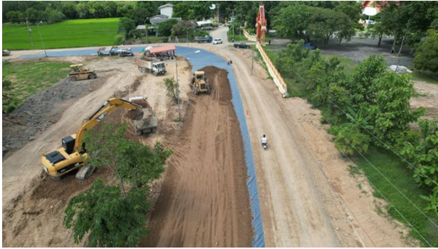
รูปที่ 16 การติดตั้งแผ่นใยสังเคราะห์ชนิดมีเส้นใยดูดซึมน้ำลงบนชั้นดินรอง พื้นทางของถนน
