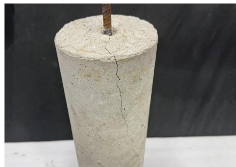
รูปที่ 20 แสดงลักษณะการวิบัติของคอนกรีตตัวอย่าง CY304S15 (เหล็ก ระยะฝัง 15 เซนติเมตร คอนกรีตกำลังอัดประลัย 304 ksc)
