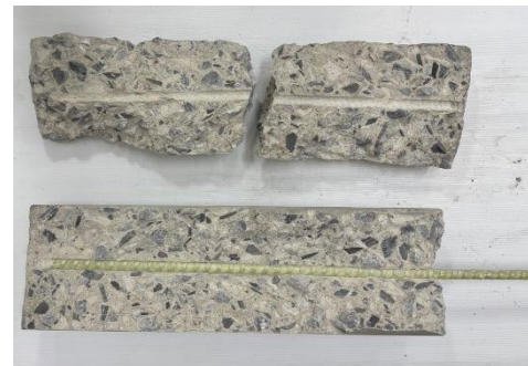
รูปที่ 13 แสดงลักษณะการวิบัติของคอนกรีตตัวอย่าง CY210G50 (GFRP ระยะฝัง 50 เซนติเมตร คอนกรีตกำลังอัดประลัย 210 ksc)
