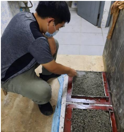
รูปที่ 3 นำส่วนผสมที่ออกแบบแล้วลงในแบบหล่อคอนกรีต
