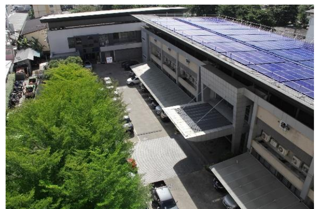
รูปที่ 1 อาคารสำนักงานศูนย์ควบคุมทางยกระดับดอนเมืองในปัจจุบัน
