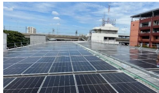
รูปที่ 6 การติดตั้ง Solar Roof Top
