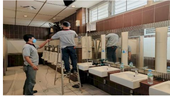
รูปที่ 5 การติดตั้งสุขภัณฑ์ประหยัดน้ำ
