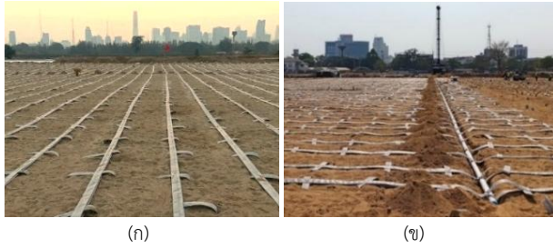
รูปที่ 9 แผ่นระบายน้ำสังเคราะห์ในแนวราบติดตั้งเข้ากับแผ่นระบายน้ำสังเคราะห์แนวตั้ง (ก) และติดตั้งเข้ากับท่อระบายน้ำรูปวงรี (ข)
