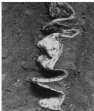
รูปที่ 8 สภาพของแผ่นระบายน้ำสังเคราะห์แนวดิ่งภายหลังการทรุดตัวในดินพีท
