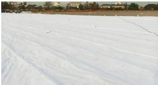
รูปที่ 11 ลักษณะการติดตั้งแผ่นป้องกันการฉีกขาด
