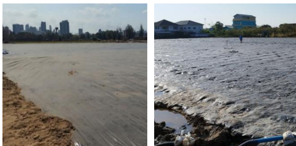
(ก) ลักษณะการติดตั้งแผ่นที่บอากาศ (ข) สภาพแผ่นที่บอากาศภายใต้แรงดูดสุญญากาศ
