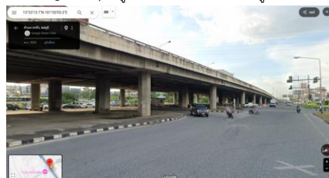
รูปที่ 3 - 1 ตัวอย่างสะพานข้ามแยกบายพาสพนัสนิคม ทล.361
