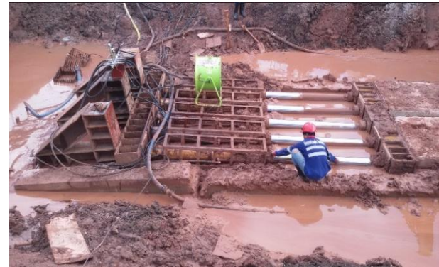
รูปที่ 23 Modify Thrust Bed (Thrust Wall) Type 1
