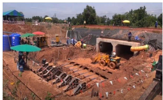
รูปที่ 19 ลำเลียงดินออกโดยใช้ Mini Wheel Loader
