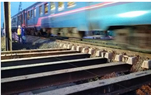
รูปที่ 21 Beam Support ขนาด 300x300 mm.
