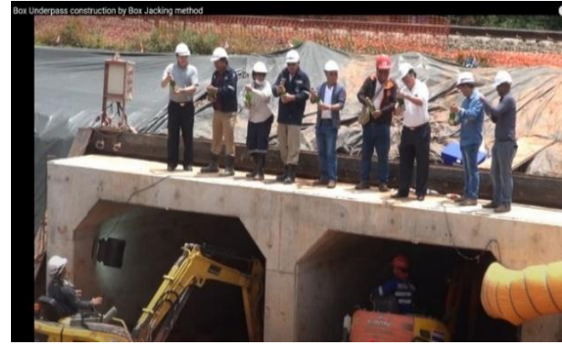
รูปที่ 28 Box No. 24 Type 3 (Box Jacking แห่งแรกของโครงการก่อสร้างรถไฟทางคู่ช่วงชุมทางถนนจิระ-ขอนแก่น (สถานีพลสงคราม)
