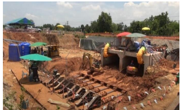
รูปที่ 18 Box Type 3 ลำเลียงดินออกโดยใช้ KUBOTA รุ่น KX91-3
