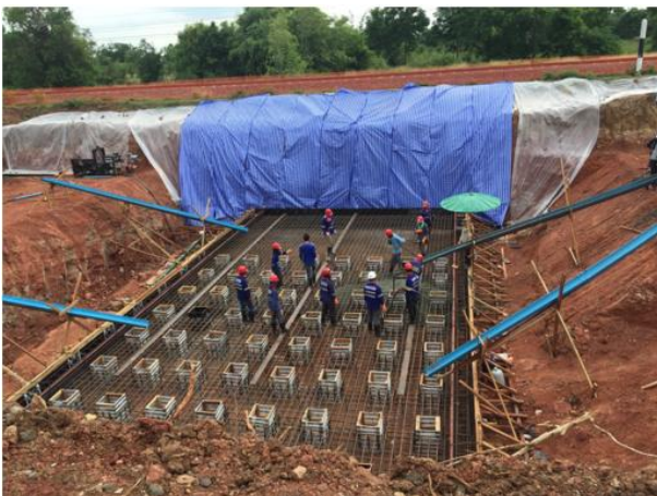
รูปที่ 12 Thrust Bed 8 Row x 8 Column
