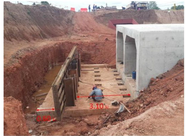
รูปที่ 13 Thrust Wall
