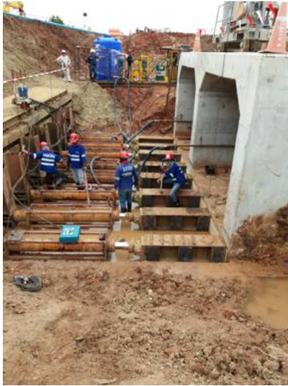
รูปที่ 15 Steel Spacer
