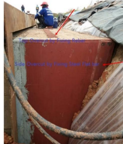
รูปที่ 17 Over Cut (Top & Side)
