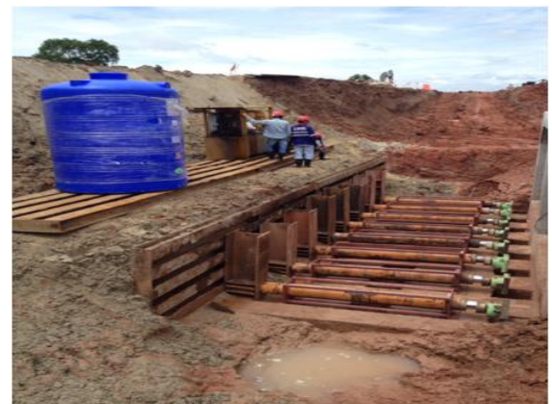
รูปที่ 14 Thrust Jack ขนาด 100 ตัน จำนวน 8 ชุด
