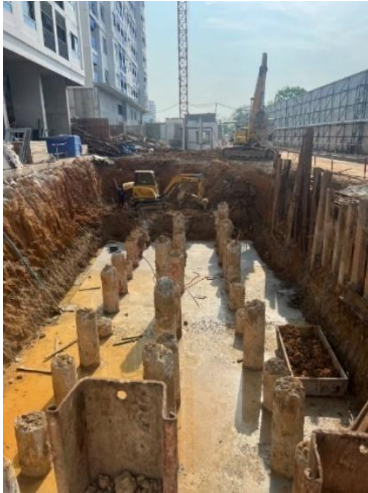
รูปที่ 1.1 น้ำเข้าสู่พื้นที่งานก่อสร้างฐานรากโครงการเอสเซน จังหวัดตรัง 2024
