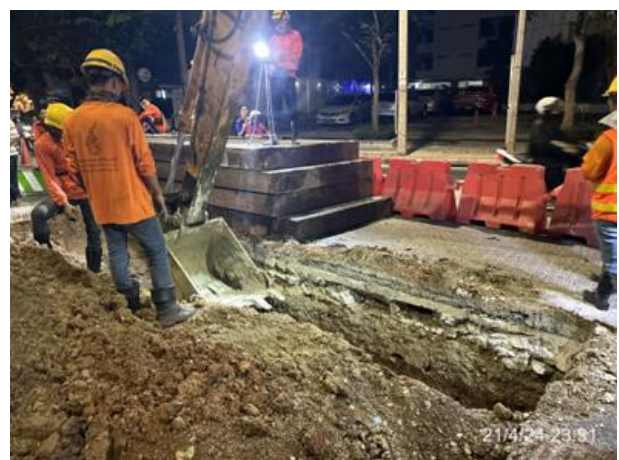
รูปที่ 4 เตรียมพื้นที่และสำรวจอุปสรรคใต้ดิน
