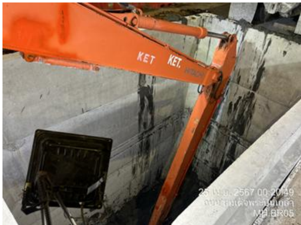
รูปที่ 6 ขุดดินภายในบ่อพักอย่างสมดุลทั้งสองด้าน เพื่อให้โครงสร้างจมลงสู่พื้นดิน
