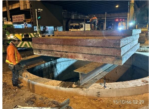
รูปที่ 7 เติมน้ำหนักในการกดจมบ่อพัก เพื่อเพิ่มแรงกดจากด้านบนและลดแรงต้านจากดินด้านล่าง
