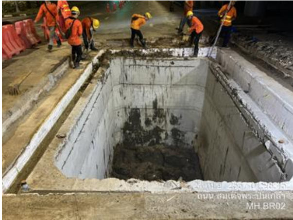
รูปที่ 5 ปรับตำแหน่งให้ตั้งตรงและได้ระดับที่เหมาะสม เพื่อป้องกันการเอียงระหว่างการถม
