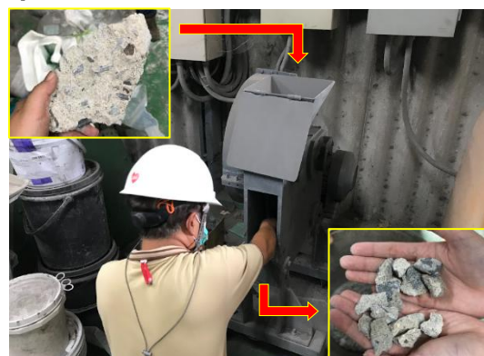
รูปที่ 1 การบดย่อยซากคอนกรีตโครงสร้างเก่าที่รื้อถอน
