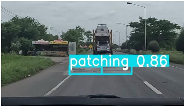
รูปที่ 12 ความเสียหายชนิดการปะซ่อม
