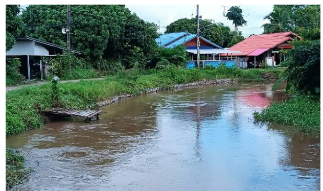
รูปที่ 28 รูปปัจจุบันหลังก่อสร้างแล้วเสร็จ
