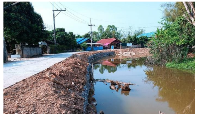
รูปที่ 27 รูปหลังดำเนินการเสริมโครงสร้างกล่องเกเบียนเรียงหินในจุดวิบัติที่ 5
