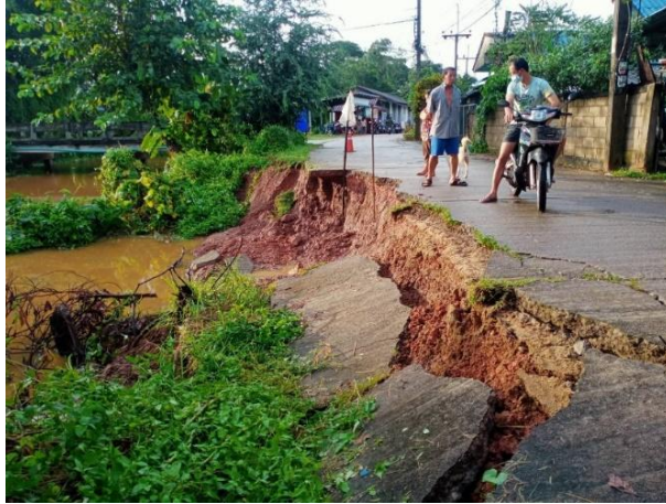
รูปที่ 2 ลักษณะลาดดินที่เกิดการพังทลาย ณ จุดวัดที่ 6
