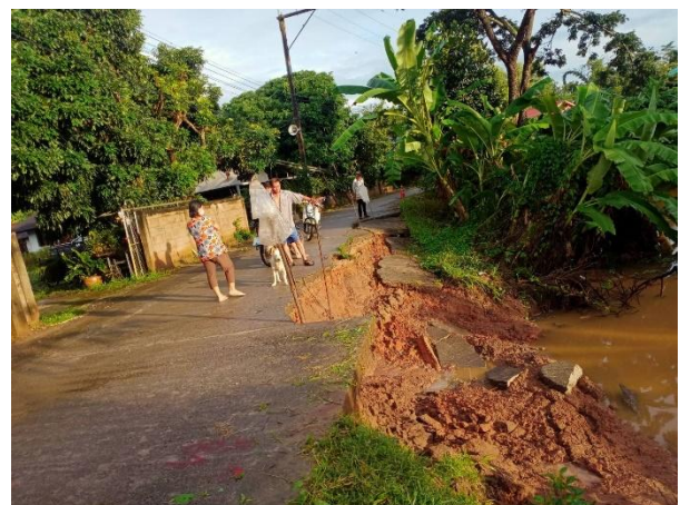
รูปที่ 25 ลักษณะการพังทลายของตลิ่งลำน้ำในจุดวิบัติที่ 5
