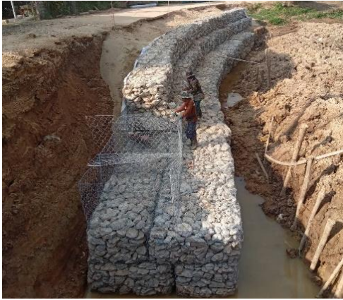
รูปที่ 26 รูปขณะดำเนินการเสริมโครงสร้างกล่องเกเบียนเรียงหินในจุดวิบัติที่ 5
