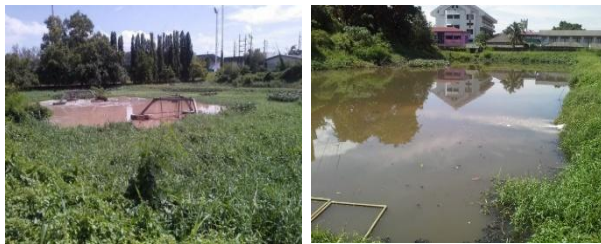
รูปที่ 1 บ่อบำบัดน้ำเสียรวมก่อนปรับปรุง
