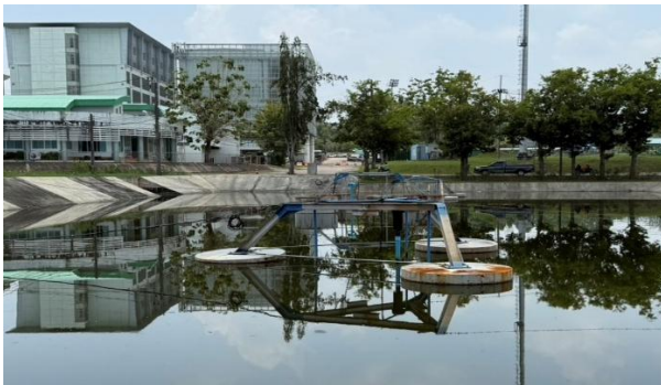
รูปที่ 5 บ่อเติมอากาศ (Aerated Lagoon)
