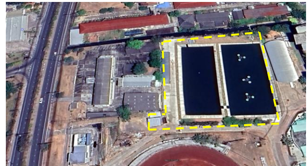
รูปที่ 3 พื้นที่บ่อบำบัดน้ำเสียรวม
