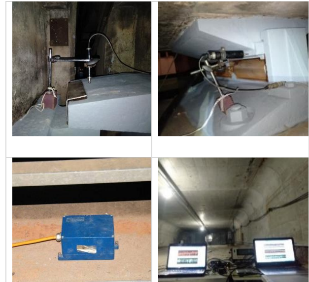
รูปที่ 12 การติดตั้งอุปกรณ์และการตรวจสอบพฤติกรรมการรับน้ำหนัก
