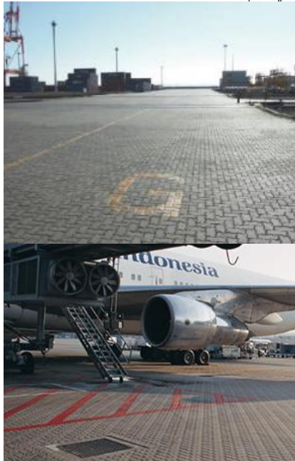
รูปที่ 1 ตัวอย่างการใช้งานคอนกรีตบล็อกปูพื้น (Concrete Paving block : CPB) [8]
