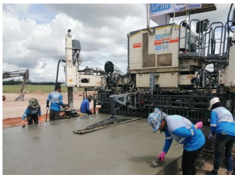
รูปที่ 20 การแต่งผิวหน้าคอนกรีตหลังเครื่องปูคอนกรีต
