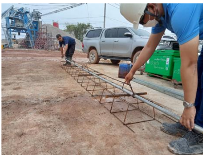
รูปที่ 17 การเตรียมเหล็ก Bar chair
