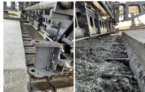
รูปที่ 30 การทำงานช่วงเปิดแบบเทต่อจากแผงคอนกรีตที่ปูแล้วเสร็จ
