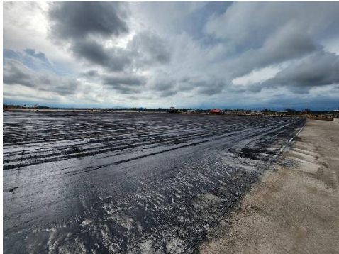
รูปที่ 16 เพิ่มชั้น (Unbonded process) โดยทางโครงการเลือกใช้กระบวนการ BST (Bituminous surface treatment)
