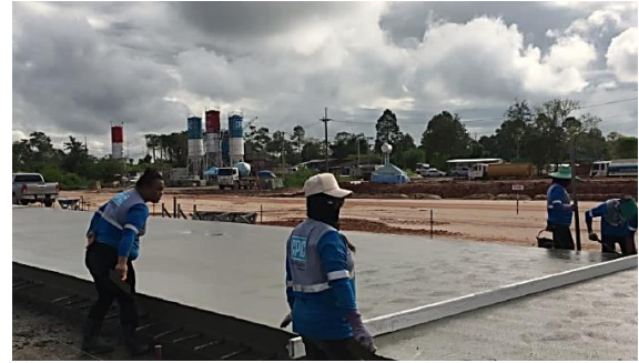
รูปที่ 21 การตรวจสอบความเรียบและเอียงของผิวทาง
