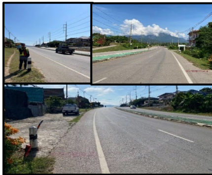
รูปที่ 14 การเก็บข้อมูลจุดสำรวจที่ 5 หลักกิโลเมตรที่ 66+229.000 (ทิศทางจราจรไปอำเภอเชียงดาว)
