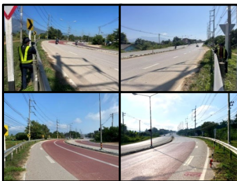
รูปที่ 8 การเก็บข้อมูลจุดสำรวจที่ 4 หลักกิโลเมตรที่ 66+525.000 (ทิศทางจราจรไปอำเภอเชียงดาว)
