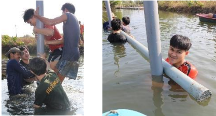
รูปที่ 22 การตอกเสาหลักลงดินที่ใต้น้ำและการติดตั้งคาน
