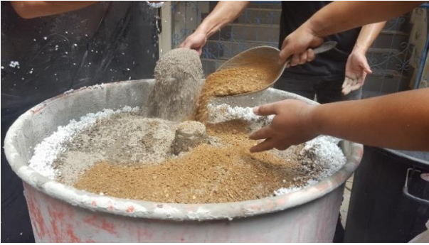
รูปที่ 4 การผสมซีเมนต์โฟมโดยใช้เครื่องผสมปูนฉาบ
