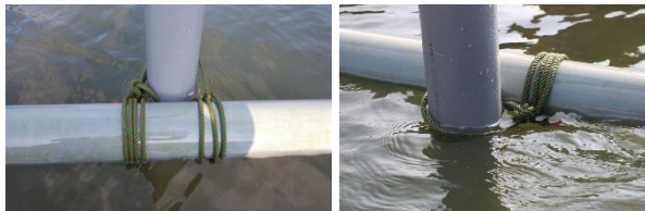
รูปที่ 23 ยึดคานเข้ากับเสาหลักโดยใช้เชือกไนลอนโดยให้คานสามารถลอยขึ้นลงตามระดับน้ำได้อย่างอิสระ
