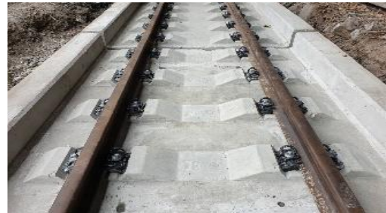
รูปที่ 4 ลักษณะของโครงสร้างทางชนิดไม้ใช้หินโรยทาง (Slab Track) (สนข. 2561)
