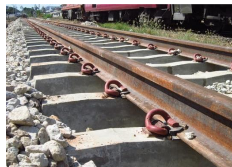
(ข) รางวางบนหมอนคอนกรีต
