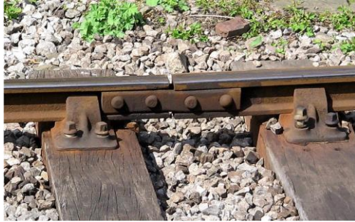
รูปที่ 15 ลักษณะของหัวต่อรางทางมีผลทำให้รางหักหรือรางร้าว
