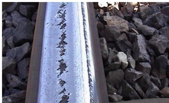
รูปที่ 5 ที่ผิวมีจุดชำรุดด้านบนหัวรางขอบด้านข้าง (สนข,2561)
