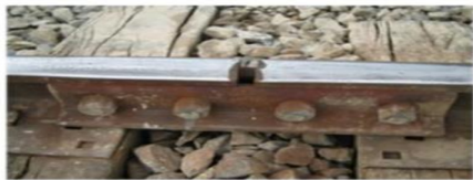
รูปที่ 15 ลักษณะของหัวต่อรางทางมีผลทำให้รางหักหรือรางร้าว
