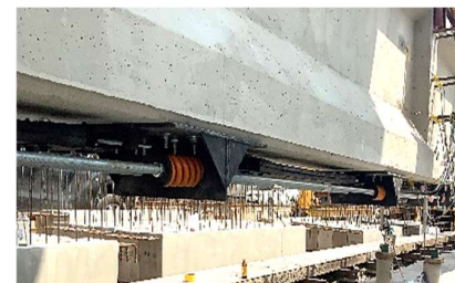
รูปที่ 9 คานรูปตัวไอ (I-Girder) หลังการเสริมกำลังด้วยแถบยางพาราอัดแรง
