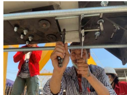
รูปที่ 8 การขันน็อตเพื่ออัดแรงแถบยางพารา
