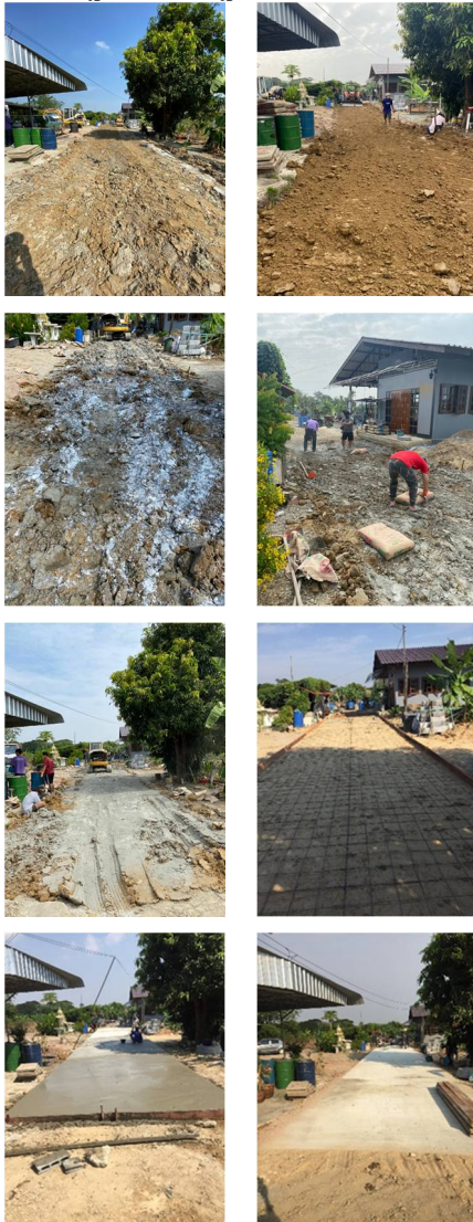
รูปที่ 4 ขั้นตอนการก่อสร้างถนนตัวอย่างในพื้นที่ อบต. หนองปากโรง อ.เมืองนครปฐม จ.นครปฐม
