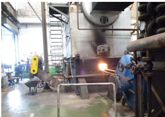
รูปที่ 1 เครื่องจักรไอน้ำที่ใช้กะลามะพร้าวเป็นเชื้อเพลิง
