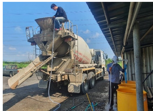
รูปที่ 2 การเติมสารละลาย NaOH ที่หน้าจุดเทคอนกรีตบริเวณหน้าด่านซึ่งเถ้าถ่านหิน
