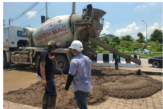
รูปที่ 4 การเทคอนกรีต
