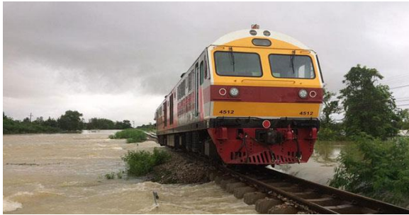
รูปที่ 1 การพัดพาชั้นหินโรยทางรถไฟในสถานการณ์น้ำท่วมใหญ่ ในปี พ.ศ. 2559 ที่ จังหวัดนครศรีธรรมราช [1]
